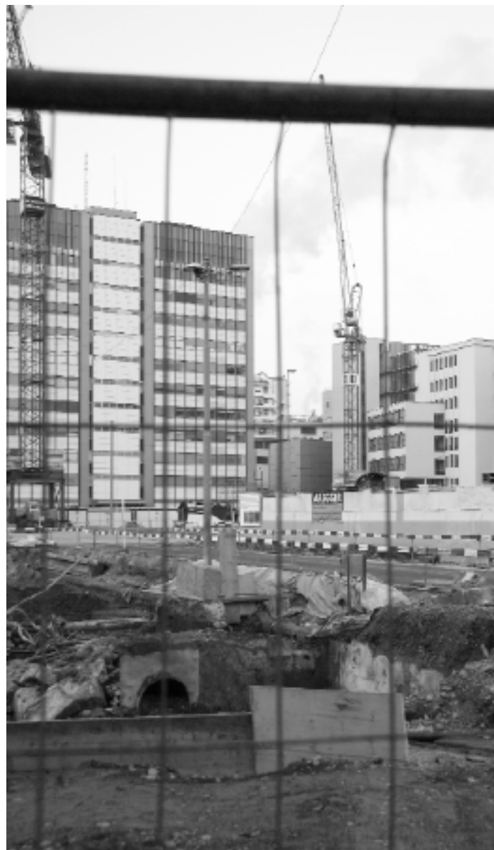
Blick auf die Baustelle.
