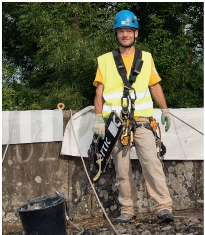
Persönliche Schutzausrüstung gegen Absturz (PSA)
